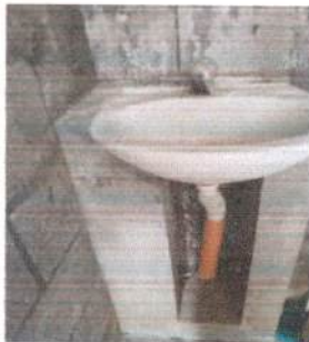
Foto 3: sustitución de lavamanos
