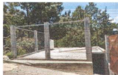
Foto 6: reparación de muro perimetral.
