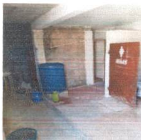
Foto 5: reparación de soleras internas, cernido y pintura
