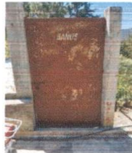
Foto 2: reparación de puerta principal
