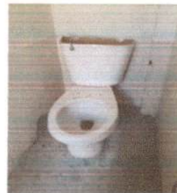
Foto 4: sustitución de inodoro
